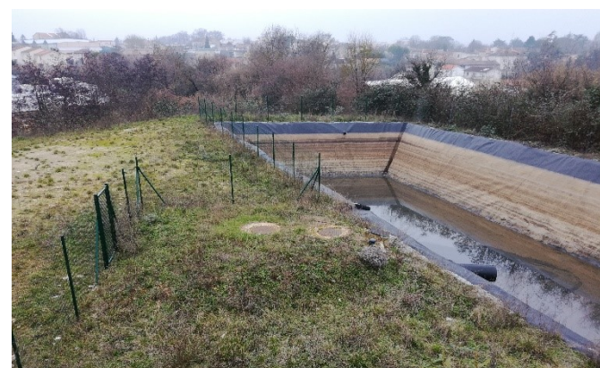
FIGURE 10 : BASSIN DE RETENTION DES EAUX PLUVIALES ET DES EAUX D'EXTINCTION D'INCENDIE
